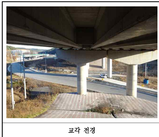
【사진 38.3.8】 교각 전경
