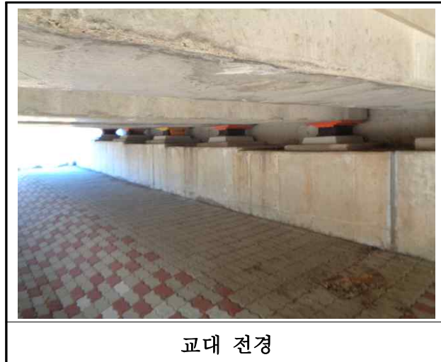
【사진 38.3.6】 교대 전경
