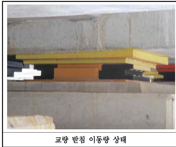
【사진 38.3.31】 교량받침 이동량 상태
