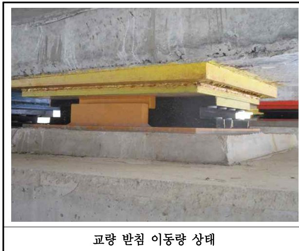
【사진 38.3.13】 교량받침 이동량 상태
