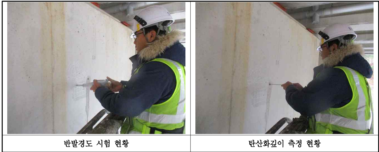
【사진 38.4.1】 콘크리트 내구성조사 현황
