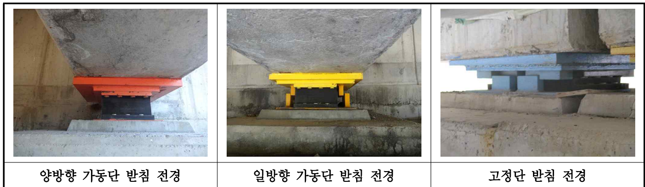
【사진 38.3.10】 교량받침 전경
