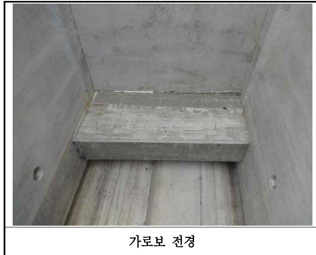
【사진 38.3.5】 가로보 전경
