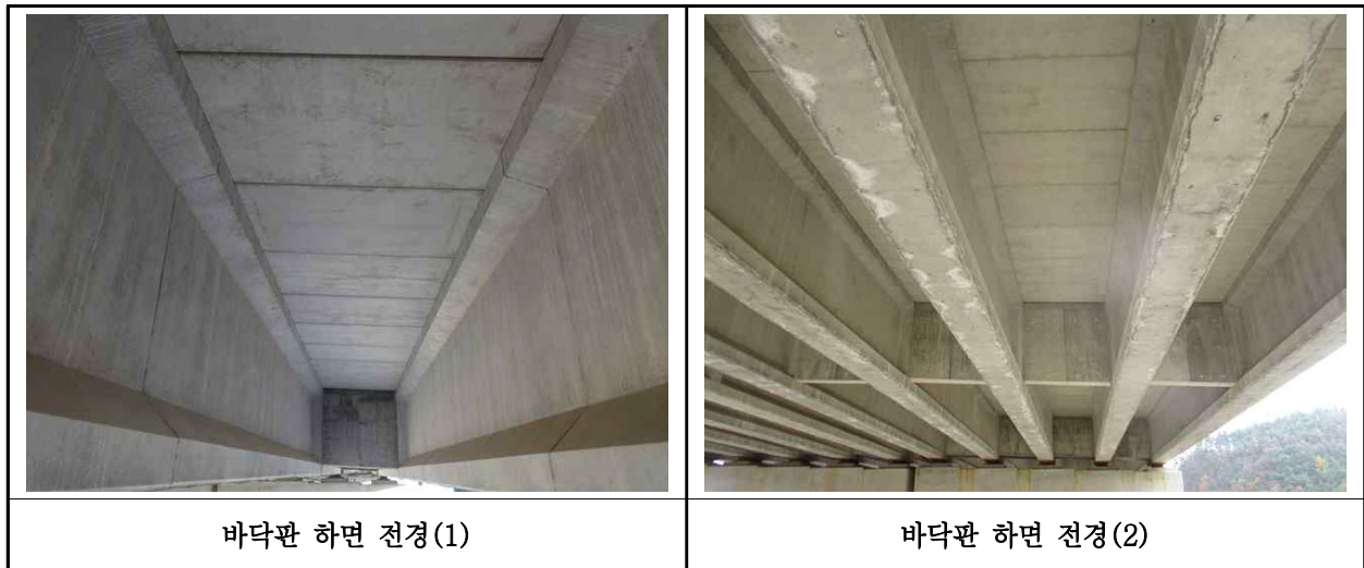
【사진 38.3.21바닥판하면 전경
