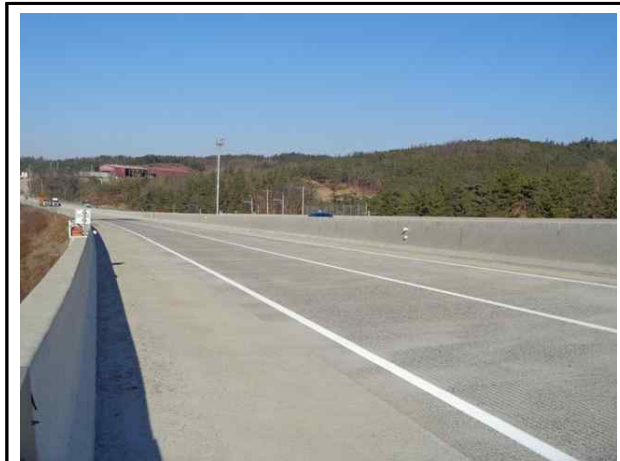
방호벽 및 중앙분리대 전경
