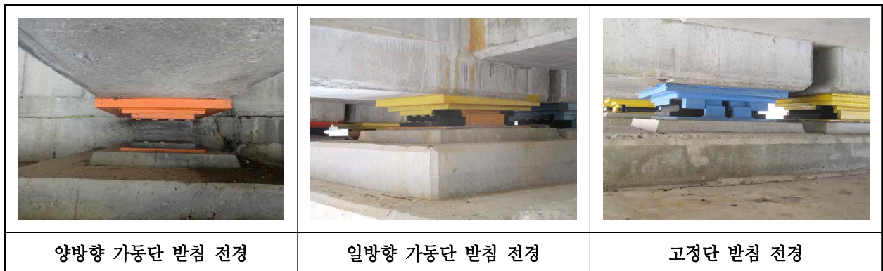
【사진 38.3.28】 교량받침 전경
