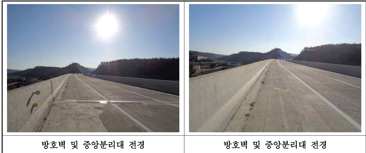
【사진 38.3.20】 방호벽 및 중앙분리대 전경
