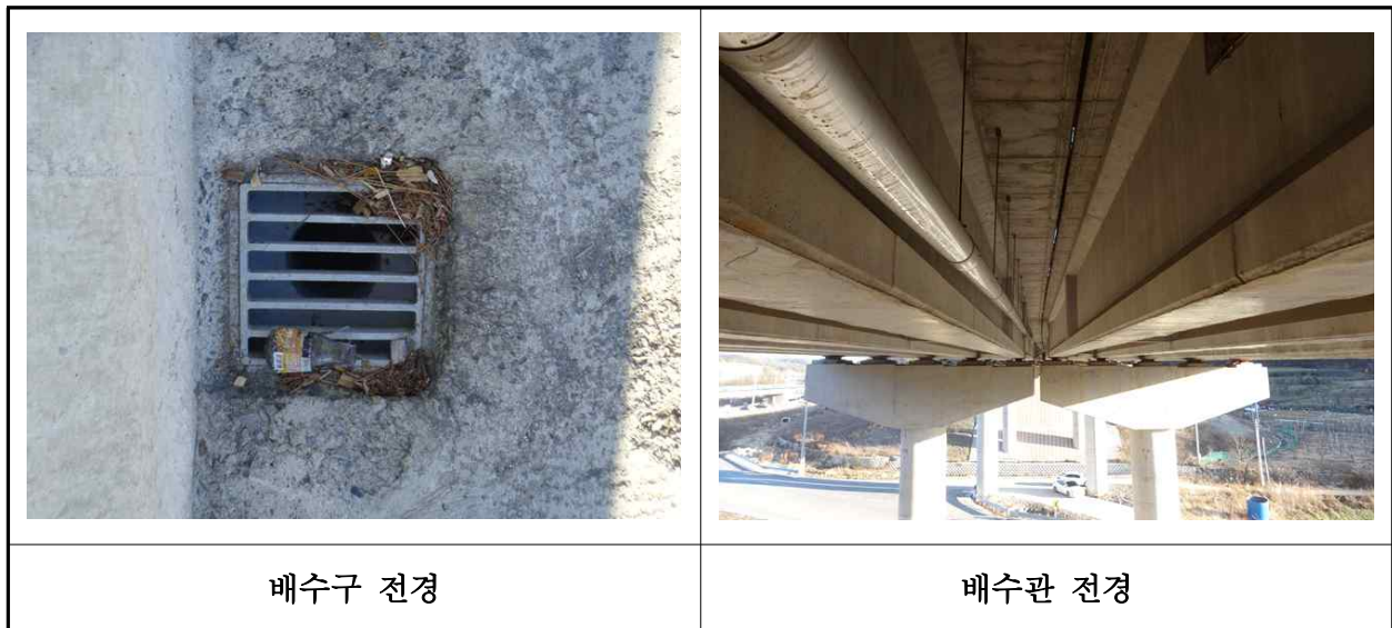
【사진 38.3.19】 배수시설 전경
